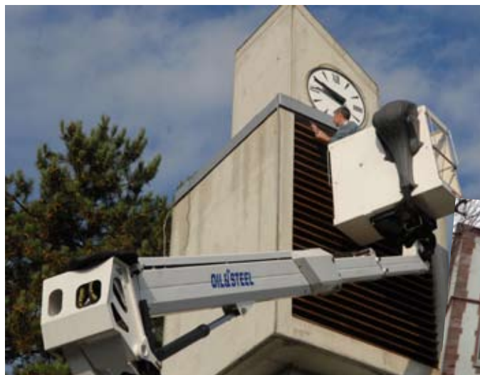
Clocher de la Chapelle St-Martin en travaux
