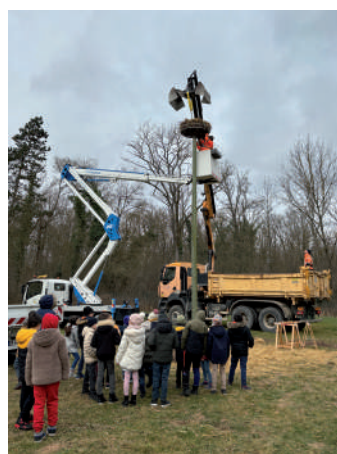
Remise en place du nid sur son mât de 8 m de hauteur.
