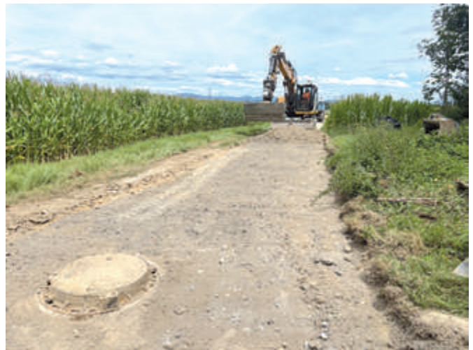
Réfection d'une partie du Mueribergweg en juillet 2025
